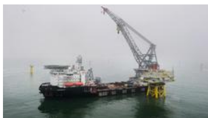
Bauarbeiten im Windpark Riffgat. An den Fundamenten der Windräder sollen im Jahr 2014 Hummer angesiedelt werden. Copyright: M. Iberler, EWE
